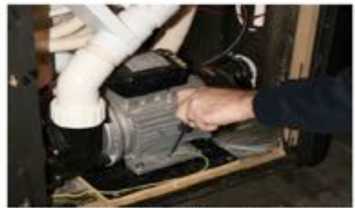
Ausbau der elektronischen Teile, Pumpen etc.; Trocken und warm lagern
